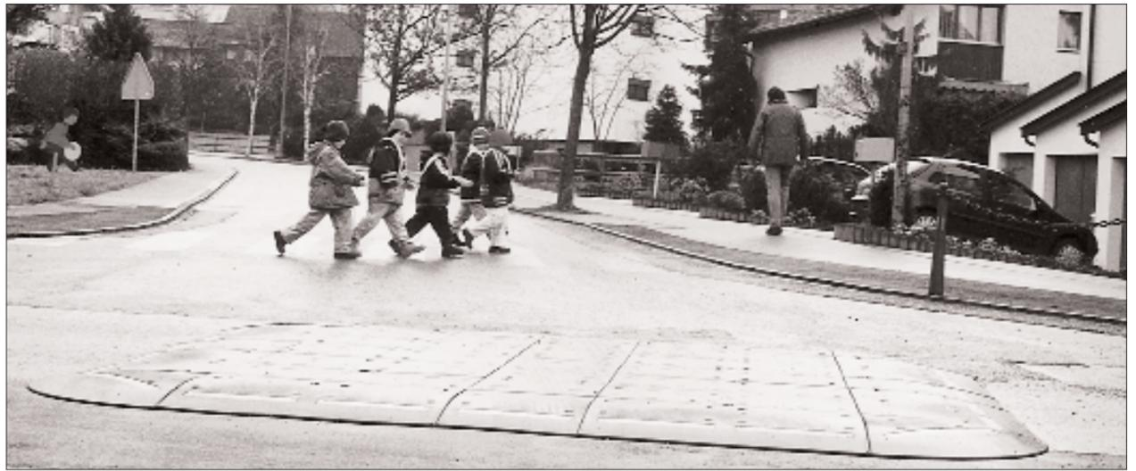
Mit zwei Delfter-Rampen wird seit Mitte Dezember die Geschwindigkeit der Fahrzeuge bei der «Äscherle»-Kreuzung in Schaan reduziert.
